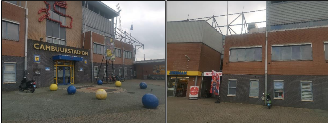
Figuur 2.3 (links): Impressie van de westelijke zijde van het stadion (hoofdingang stadion en kantoorgedeelte); Figuur 2.4 (rechts): Impressie van het kantoorgedeelte, links naast de hoofdingang. Boven de eerste verdieping is de gevel opgebouwd uit metalen platen, de rest bestaat uit gemetselde muren met stootvoegen.
