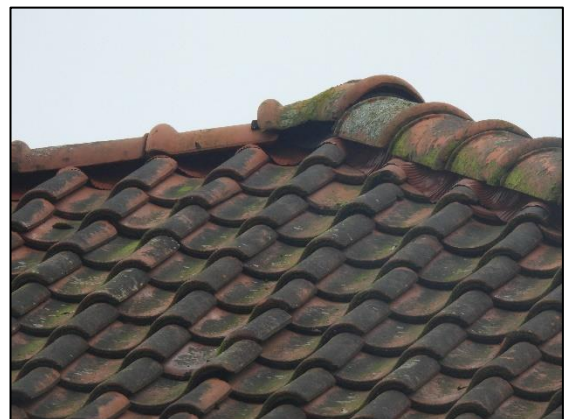
Afbeelding 2.14. Dakpannen dak woningcomplex.
