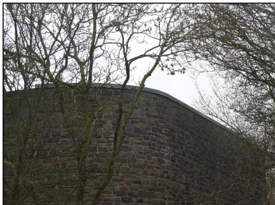
Afbeelding 2.15. Kerk met 'rotsachtige' muur en dakbedekking.
