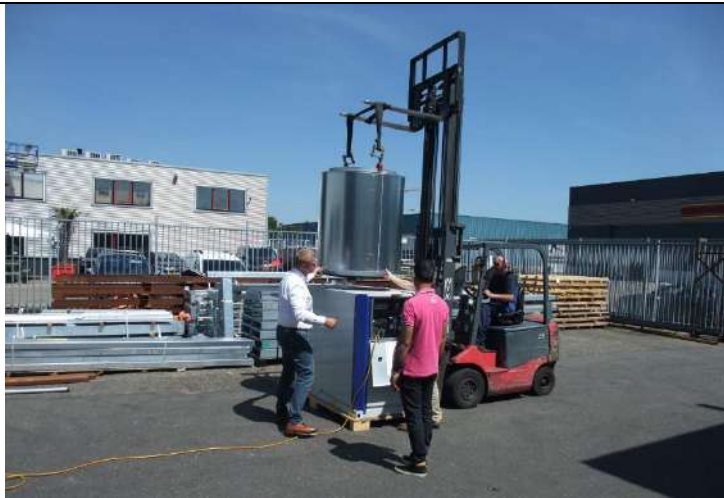
Plaatsing geluiddemper op Carrier unit bij leverancier (ander project)
