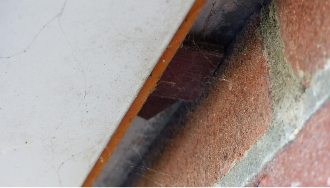
Afbeelding 5 De donkere stukken die te zien waren vanaf de weg, blijken in werkelijkheid stukjes hout. Er zijn geen gaten aanwezig.
