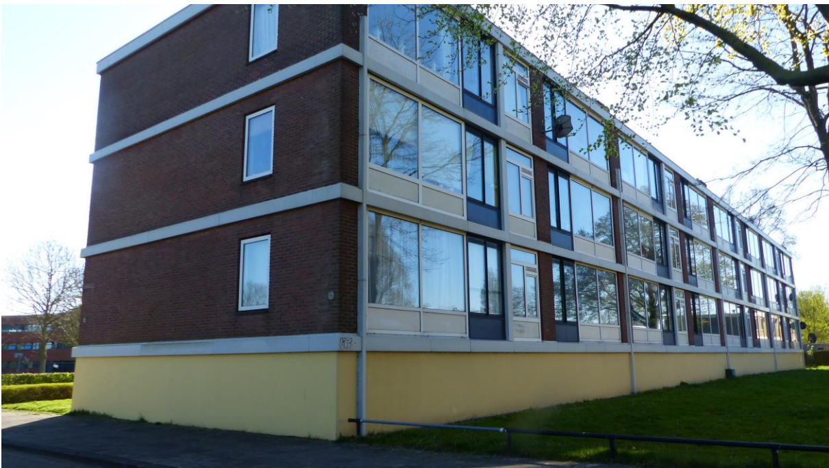
Afbeelding 4 Achterzijde van de flat aan de Schieringerweg.
