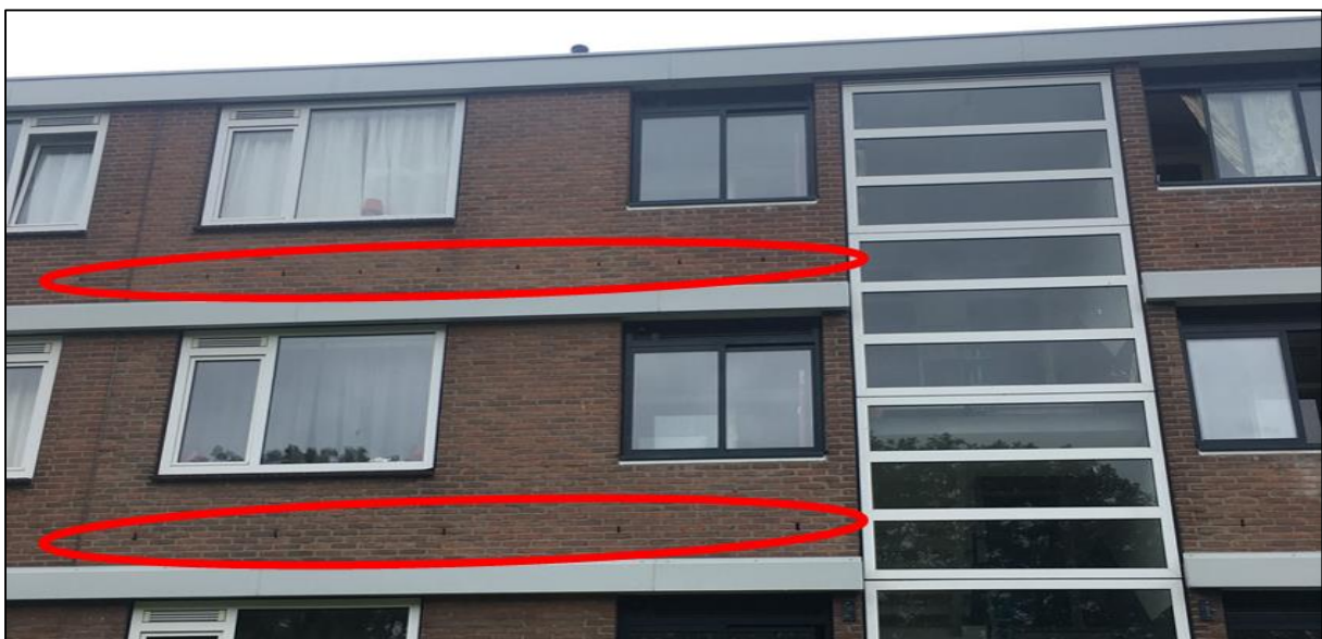
Figuur 2.2. Mogelijke (toegang tot) verblijfplaatsen voor vleermuizen middels stootvoegen.
