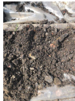
meetpunt 13, laag 17-60, bijz. asfalt 427108563
