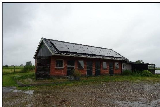
Afbeelding 2.4. De te slopen stal.
