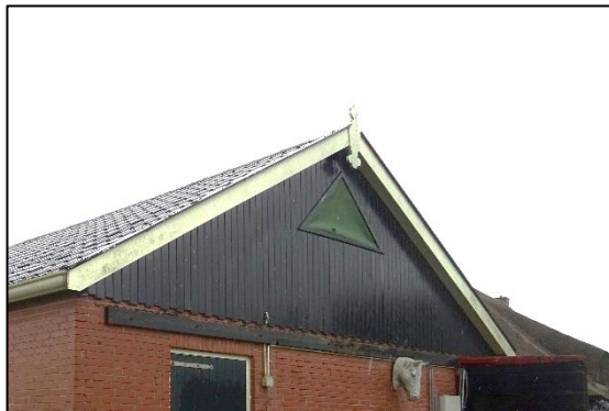
Afbeelding 3.5. Kopgevel met houten gevelbekleding.
