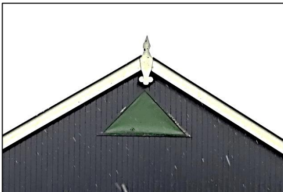
Afbeelding 3.3. Ventilatiegaten afgedicht met gaas.
