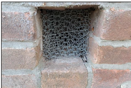
Afbeelding 2.7. Ventilatiegaten met gaas ervoor.
