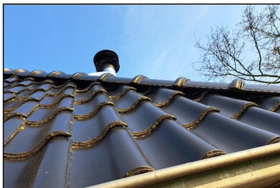
Afbeelding 2.6. Dakpannen met loodflappen eronder.
