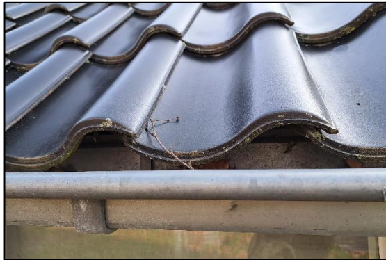
Afbeelding 3.3. Ruimte onder de dakpannen, bereikbaar vanaf de dakgoot.
