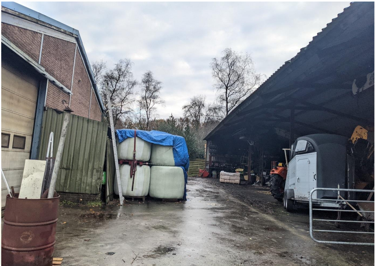
Figuur 4. Twee gebouwen binnen het plangebied welke niet worden gesloopt.
