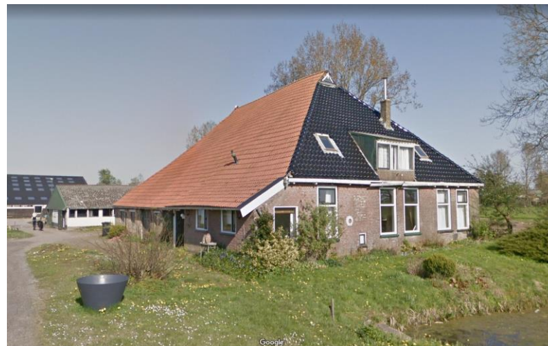
Figuur 2.2: Zicht op bedrijfswoning in huidige situatie vanaf de Burdinewei (bron: google maps)
