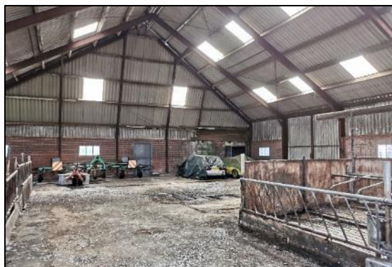
Afbeelding 2.7. Binnenkant van de aangebouwde stal.
