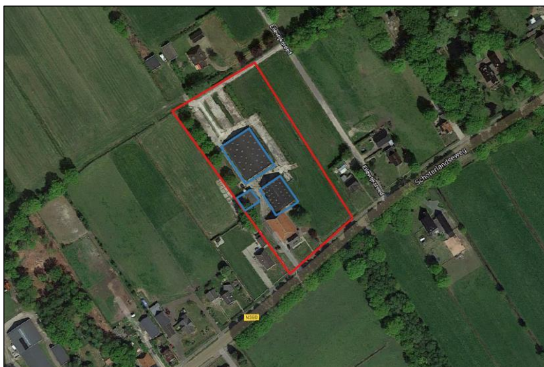
Afbeelding 2.1. Begrenzing van het plangebied (rood omlijnd) en de te slopen bebouwing (blauw omlijnd) (Bron achtergrond: Esri).
