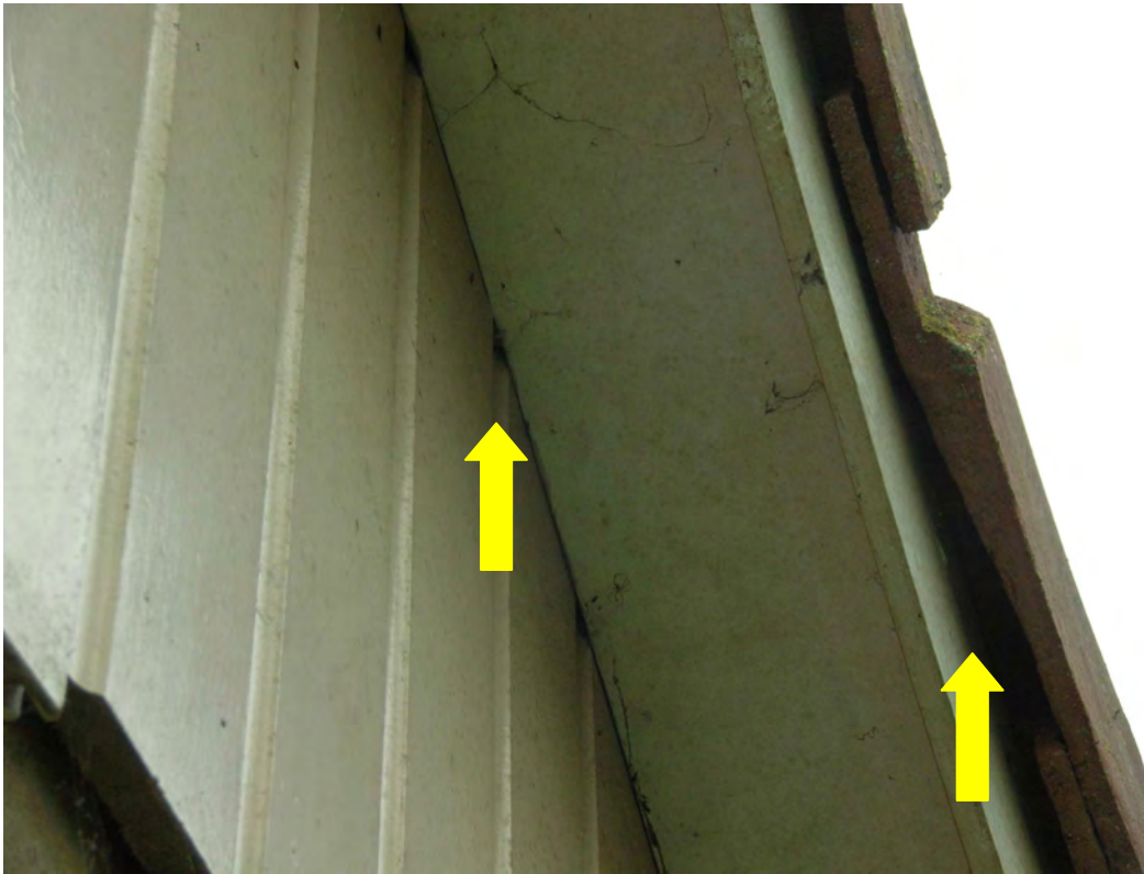
Figuur 4: Potentiële verblijfplaatsen voor vleermuizen in het clubgebouw.
