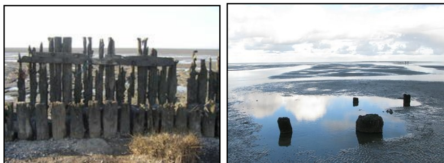
Figuur 8. Links een palenschermbank bij Moddergat (bron: Google Maps). Rechts de resten van palen van een baak op de Engelsmanplaat (bron: www.verdronkengeschiedenis.nl )
