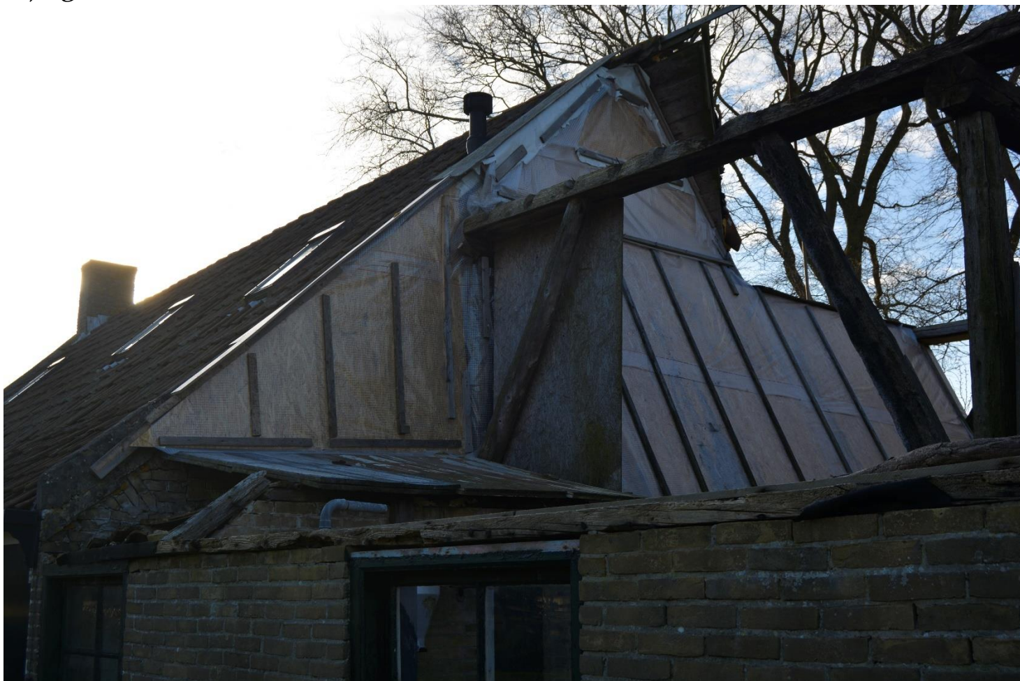
Figuur 2 Scheiding tussen het voorpand en de voormalige stal. Zoals te zien, in de afbeelding, is deze volledig bedekt met plastic om vocht, wind en dieren buiten te houden.
