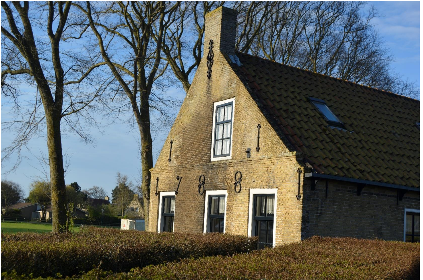
Figuur 8 Aanzicht van de voorzijde van het voorpand. Hierbij is te zien dat er tussen de dakpannen en de gevel van het huis geen ruimte is voor mogelijke vleermuisverblijfplaatsen.
