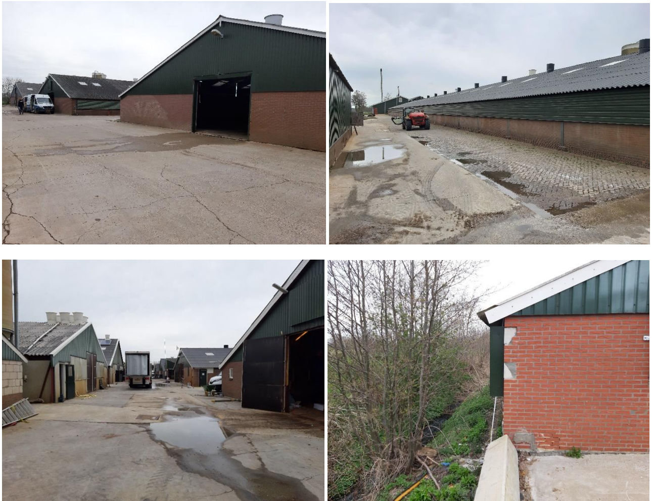
Figuur 3a. Foto's bestaande situatie (lb. 6,7,8) (rb ruimte uitloop 5) (lo overzicht) (ro te slopen stal 3).
