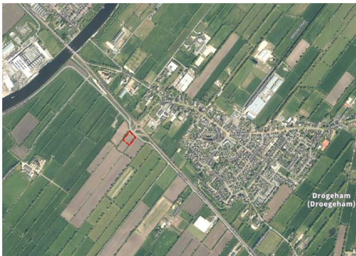
afbeelding 1: locatie nieuw regelstation met rood aangeduid (bron: pdok.nl)
