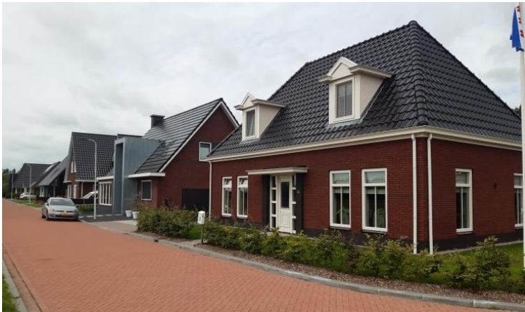
Figuur 9. Foto bestaande bebouwing
