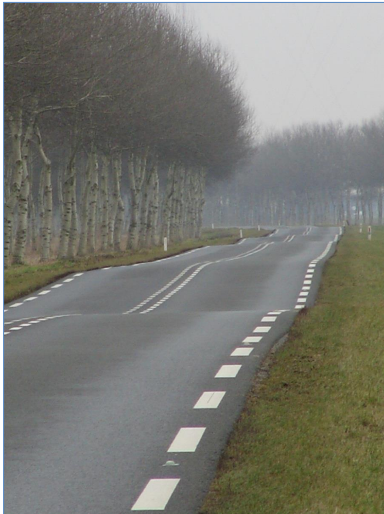
Figuur 14: Het golvend reliëf van de Vogelweg is een gevolg van de differentiële klink van prehistorische getijdengeulen. Foto: A.A. Kerkhoven.
