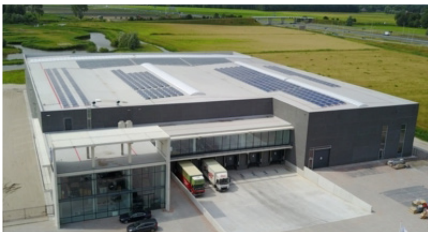
Zonnepanelen op daken
