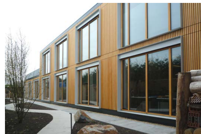
Milieuvriendelijke materialen; onverlijmd prefab massief hout
