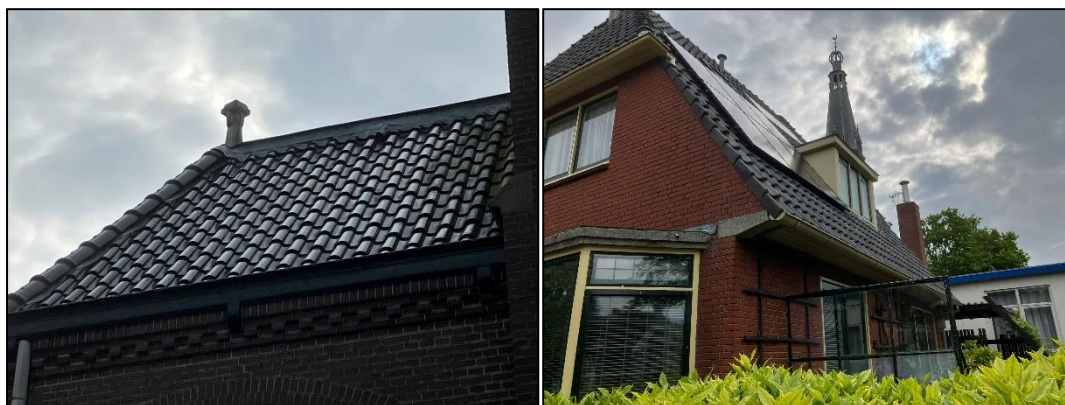
Figuur 6.4 (links): De dakpannen van de kerk ten noorden van het plangebied; Figuur 6.7 (rechts): De dakpannen van woning (nr. 84) ten noordwesten van het plangebied.
