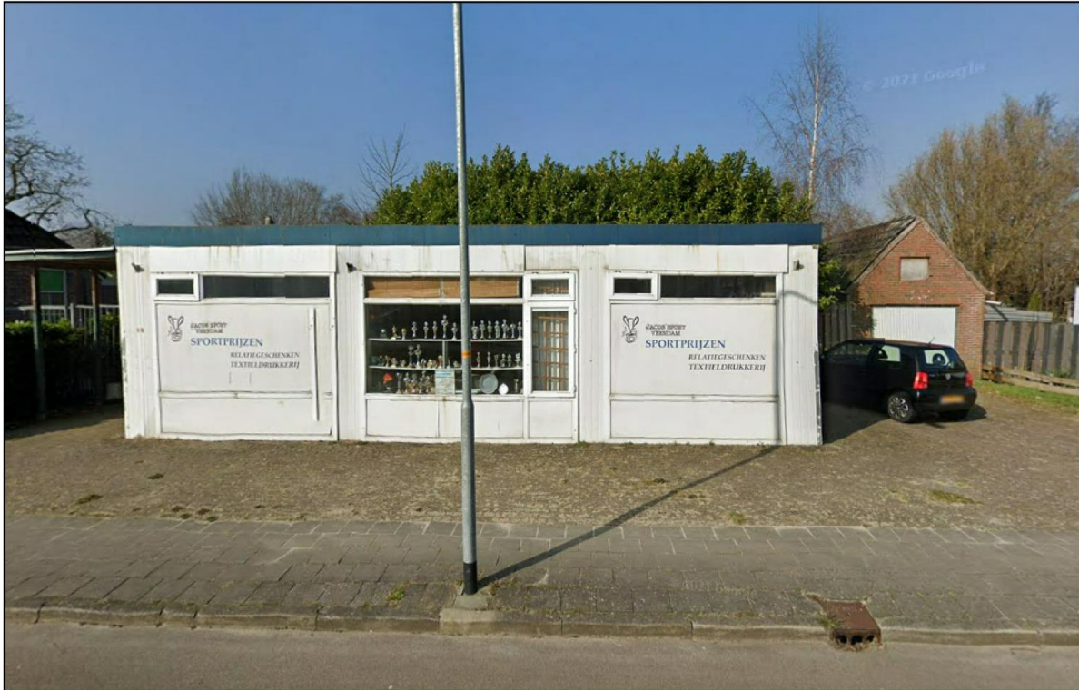
Afbeelding 2.2 Straatbeeld Beneden Verlaat 60 (Bron: Google Streetview)
