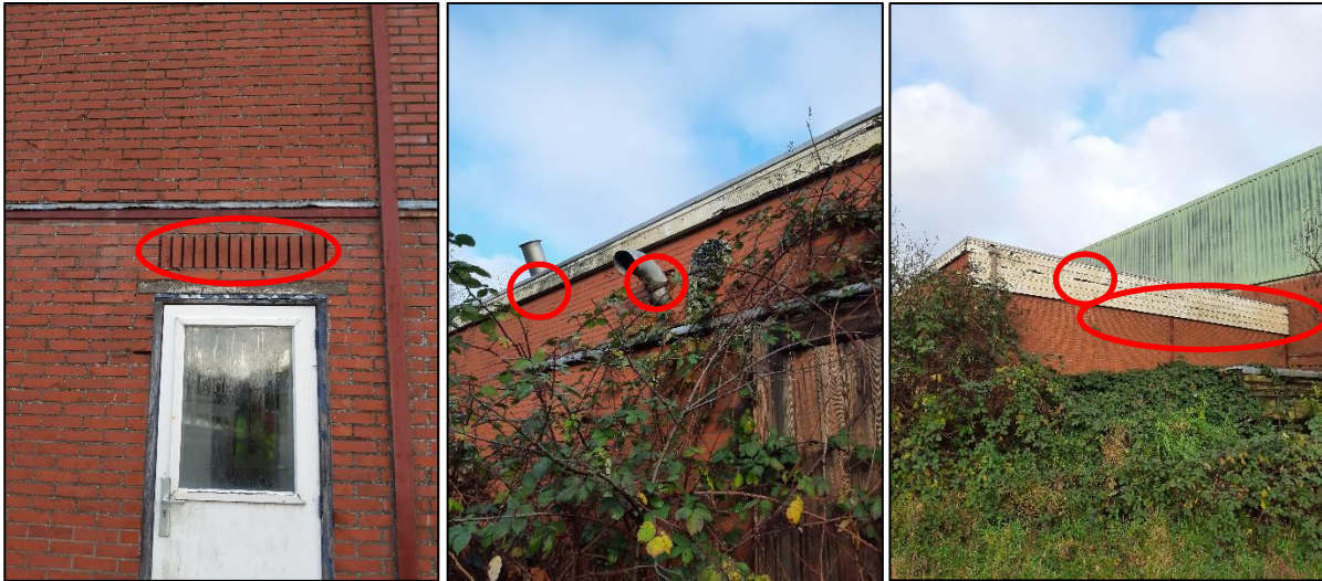
Figuur 6 De loods bevat openingen naar de spouw in de vorm van open stootvoegen (links). Tevens bevat het bijgebouw gevelbetimmering met openingen en spleetvormige ruimten (midden en rechts).
