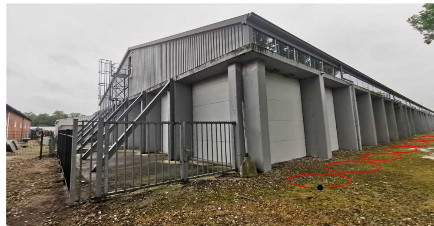
Foto 1 Positie 6 silo's indicatief
