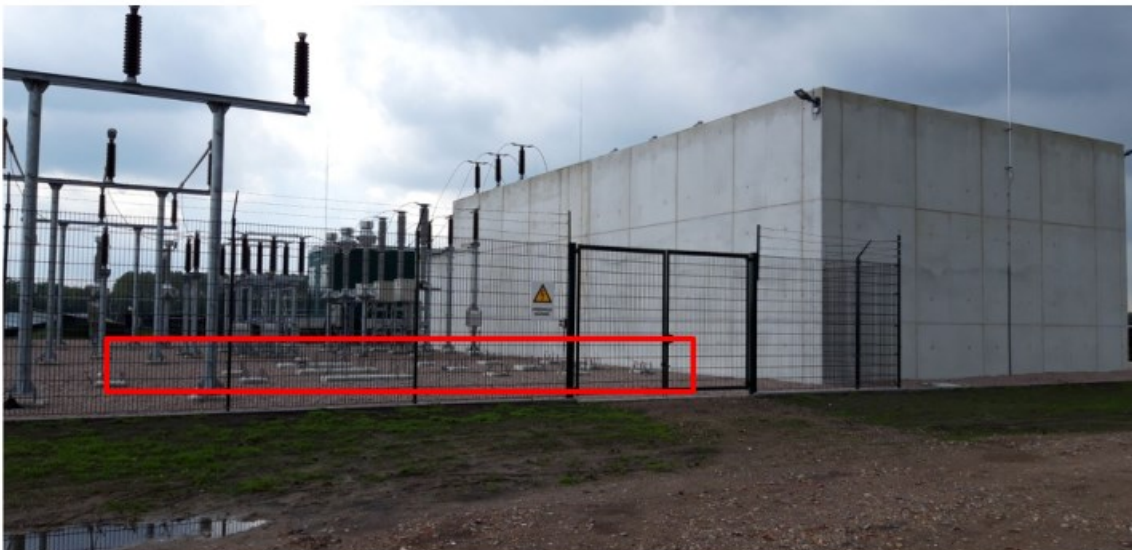
Figuur 2.8 Aanzicht op de schakeltuin (de rode kader weergeeft de fundering van de toekomstige schakeltuin)
