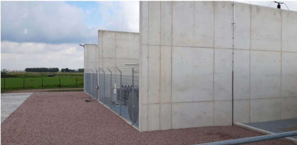
Figuur 2.5 Zijaanzicht; rechts bestaande trafo, links compartiment voor uitbreiding (2e trafo)
