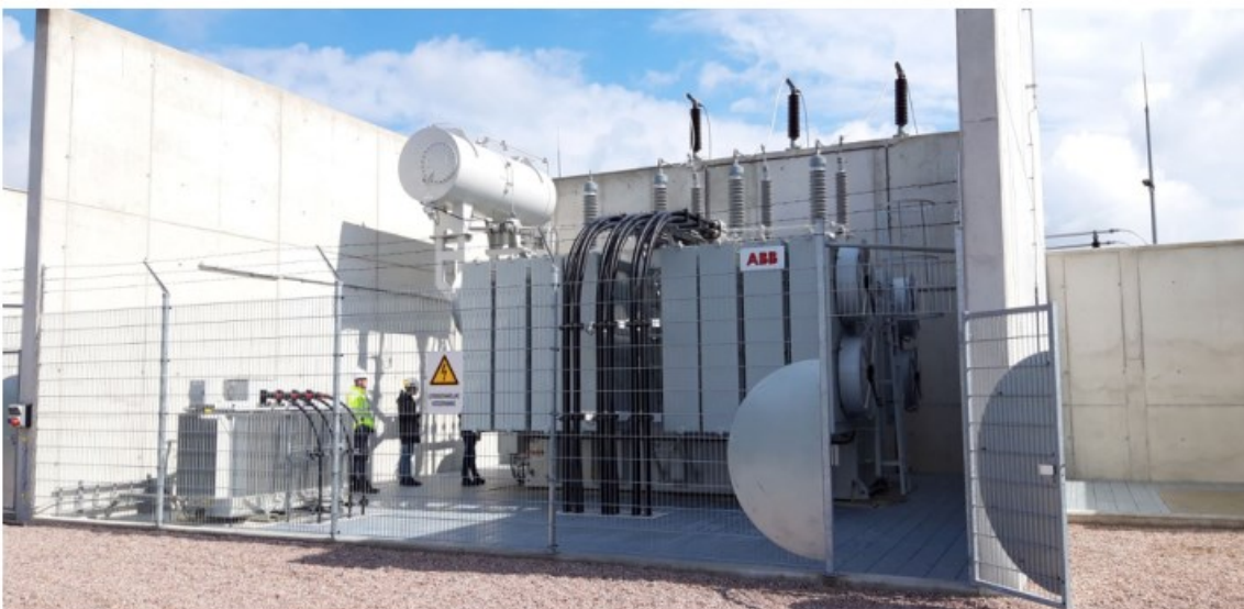
Figuur 2.5 Zijaanzicht; rechts bestaande trafo, links compartiment voor uitbreiding (2e trafo)
