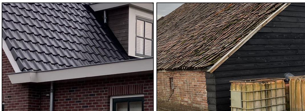
Figuur 6.1 (links): Impressie van het pannendak aan de zijde van het nieuw te bouwen bijgebouw aan de bedrijfswoning; Figuur 6.2 (rechts): Impressie van het pannendak van de bestaande schuur.
