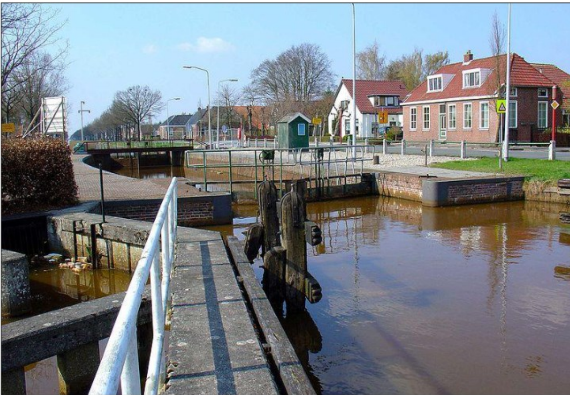
Figuur 20 1 ste Verlaat of Springersverlaat in het Stadskanaal, gebouwd in 1788.
