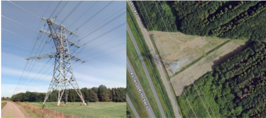
Figuur 2.2: Mast 201 (L: zijaanzicht, R: bovenaanzicht) (bron: Cyclomedia)
