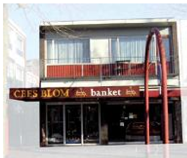
Gevelbeeld wordt verstoord door luifel (voor de verbouwing)
