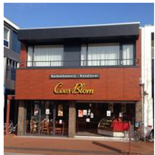
Enheid in gevelbeeld (na de verbouwing)
