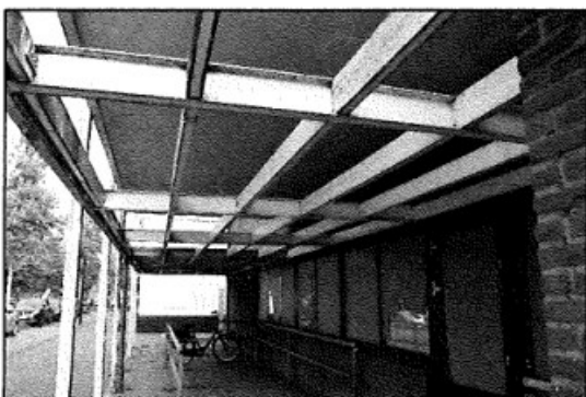
Afbeelding 2.6. Ingang pand, gezien vanaf oosten.
