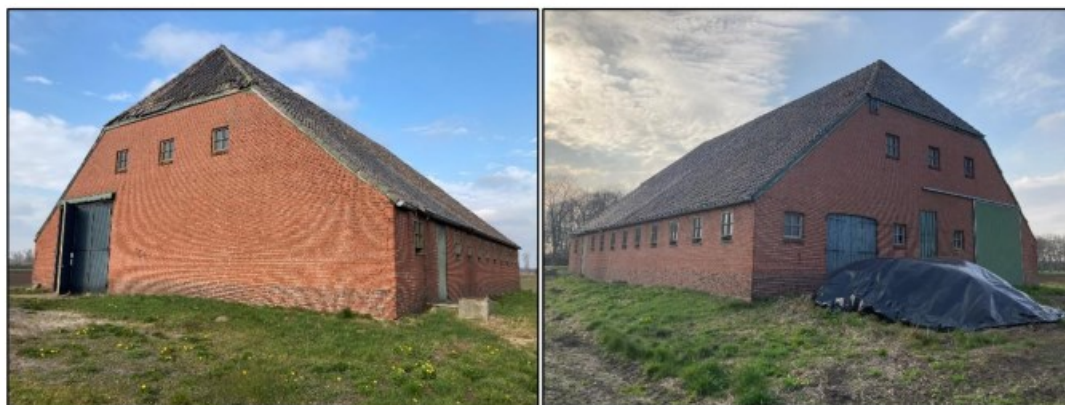
Figuur 2.11 (links): De schuur heeft een pannendak en gemetselde muren. De muren bevatten geen stootvoegen; Figuur 2.12 (rechts): De oostzijde van de schuur, hier ligt ook opslag van materialen onder een zeil.
