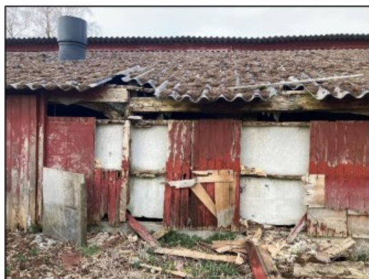
Figuur 6.5: Openingen in de bebouwing maken het toegankelijk voor marterachtigen.
