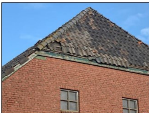
Figuur 6.5: Ruimten tussen dakpannen en isolatiemateriaal.
