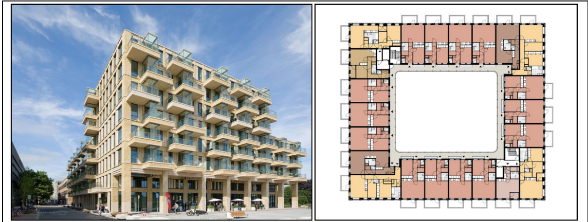
Figuur 4.8: Geheel verglaasde buitenruimte, gesloten balkons met ventilatie ('Square' in Amsterdam, LEVS architecten)
