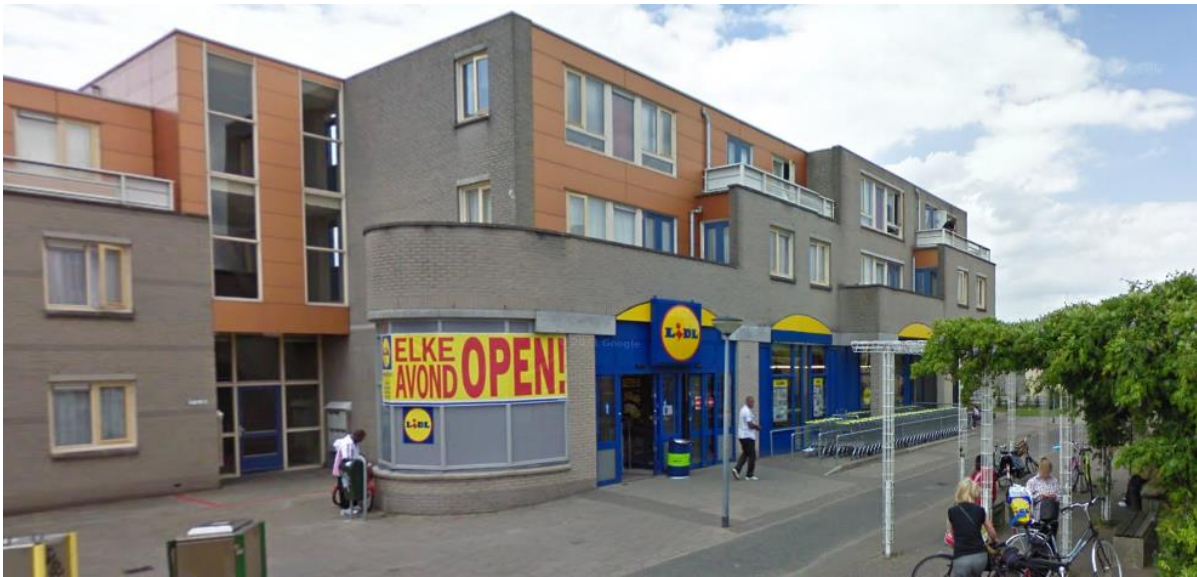
Afbeelding 2.6: Bestaande situatie plangebied
