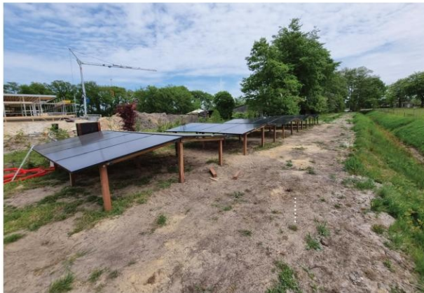
referentiebeeld zadeldakopstelling, hoogte, kleur en constructie
