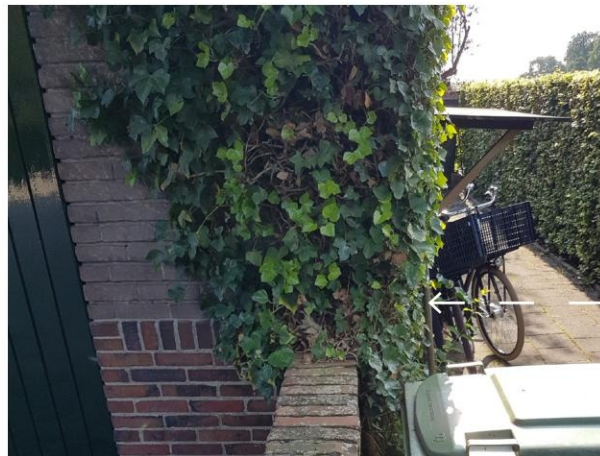
kabel onder voetpad door tot aan buitenmuur
