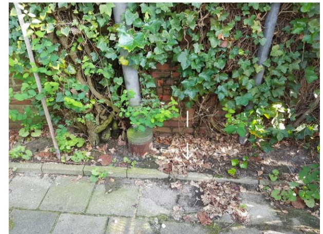
kabel bij buitenmuur verder de grond in en langs fundering naar kruipruimte en meterkast
