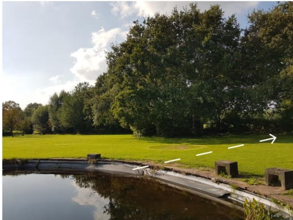
kabel van vijver door gras richting houtsingel
