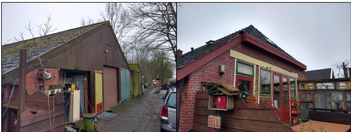
Figuur 1.2. Een impressie van de bebouwing binnen het plangebied te Groningen, met de schuur (links) en het woonhuis (rechts).
