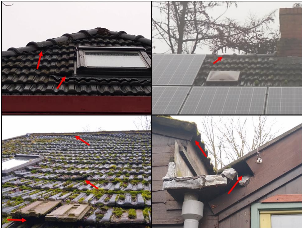
Figuur 2.2. Impressie aanwezige ruimtes bij de woning (boven) en de schuur (onder) waar o.a. huismussen kunnen verblijven.
