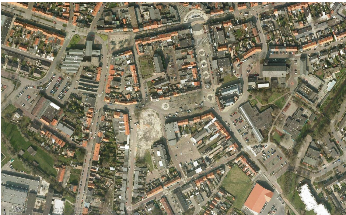
Situatie na sloop
