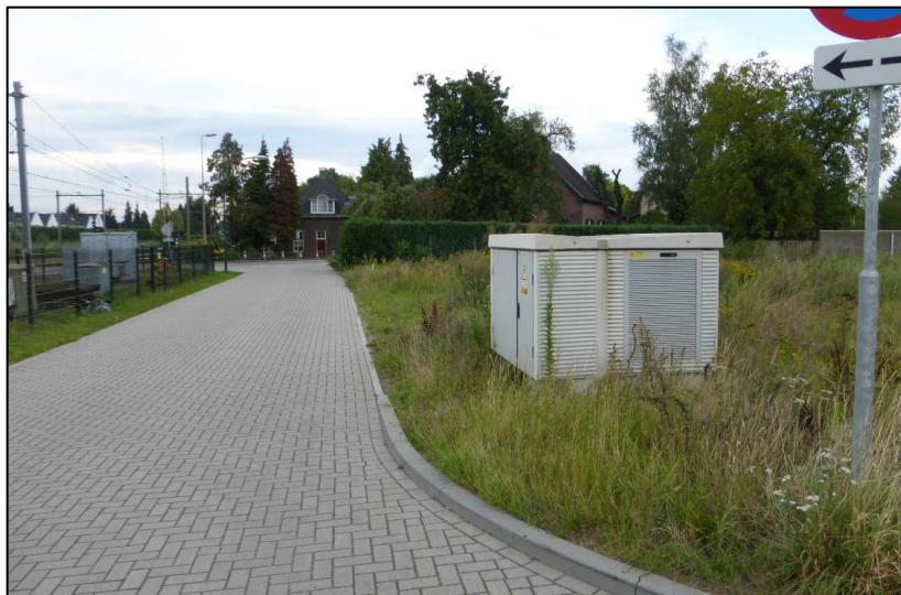
Figuur 10: Beeld van ontsluiting voor de planlocatie en van de brandweerkazerne aan de zuidwestzijde van de planlocatie (deze ontsluiting wordt niet gebruikt)
