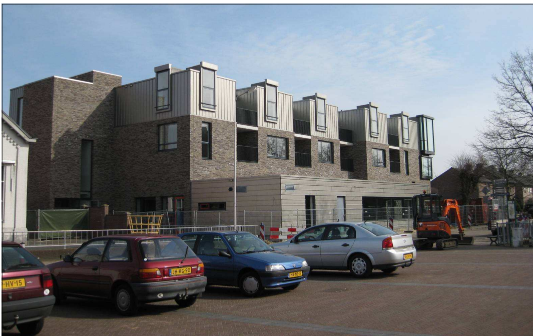
multifunctionele accommodatie met school in aanbouw
