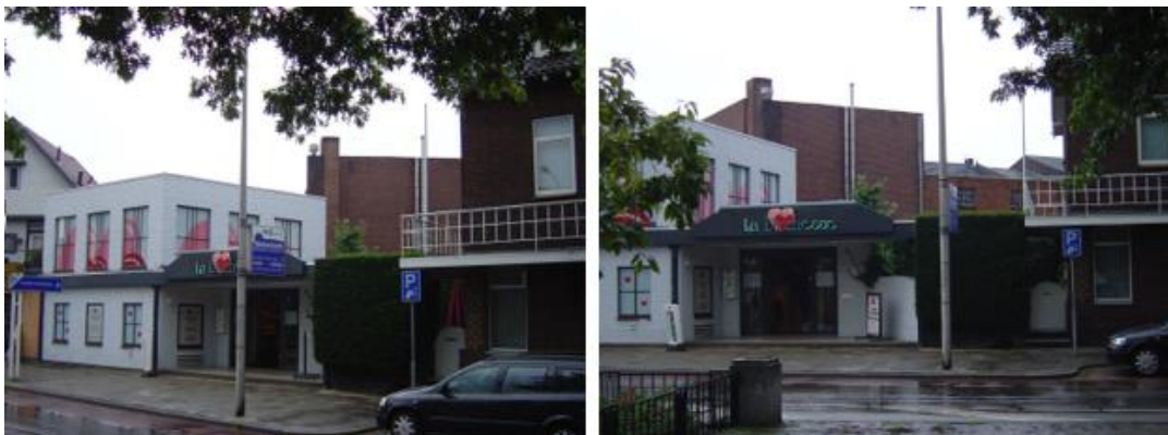
Zicht op de voormalige bebouwing van de kaarsenfabriek
