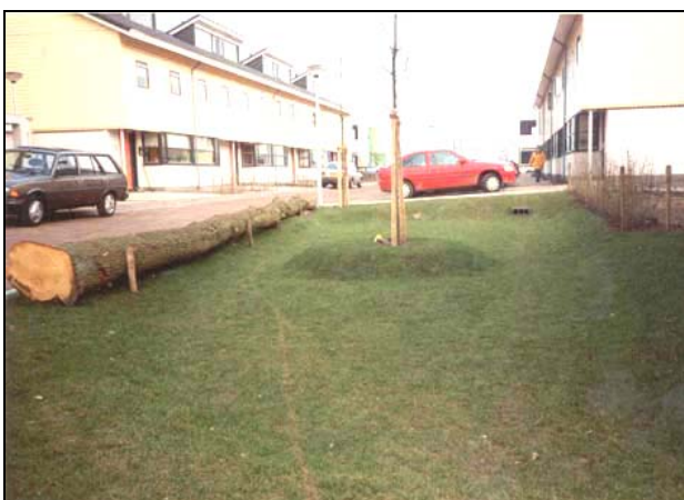
Afbeelding 4.1: Praktijkvoorbeeld van oppervlakte-infiltratie (veld/greppel/bassin)
