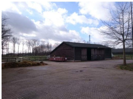
Houten schuur die gesloopt gaat worden
