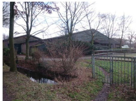
Paardenstallen die gesloopt gaan worden
