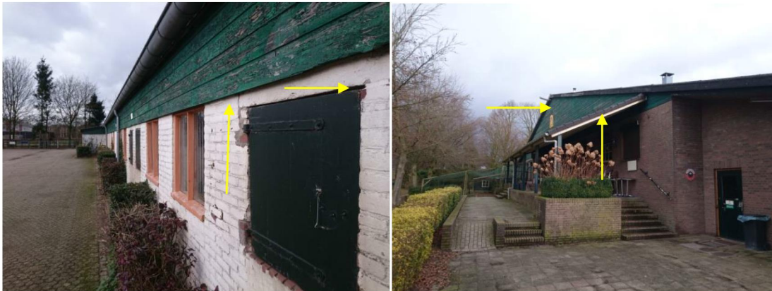
Figuur 2.2: Potentieel geschikte verblijfplaatsen voor vleermuizen in de paardenstallen, in kieren en achter houten gevelbetimmering en overhangende dakpannen.
