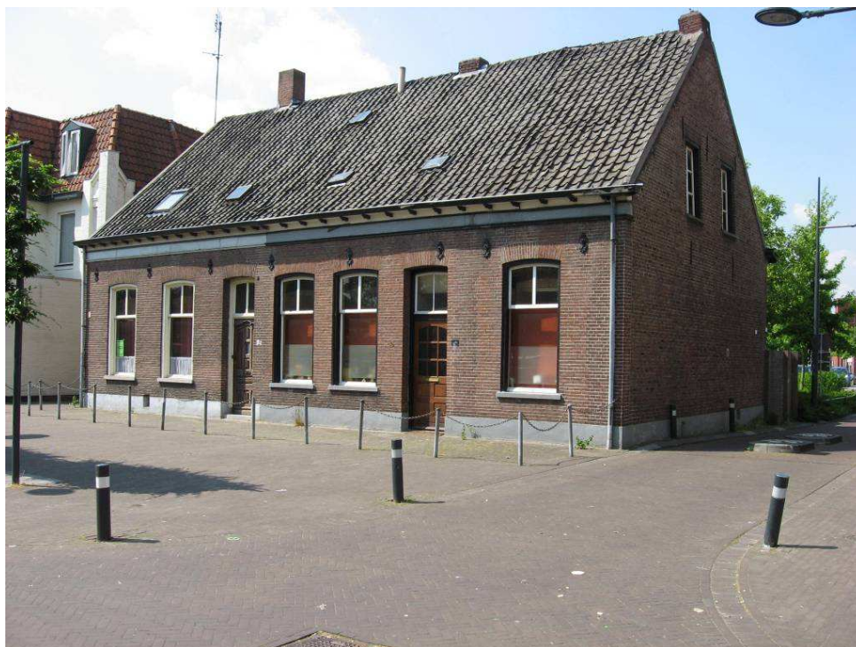
De voorzijde van het dubbelpand uit 1889
