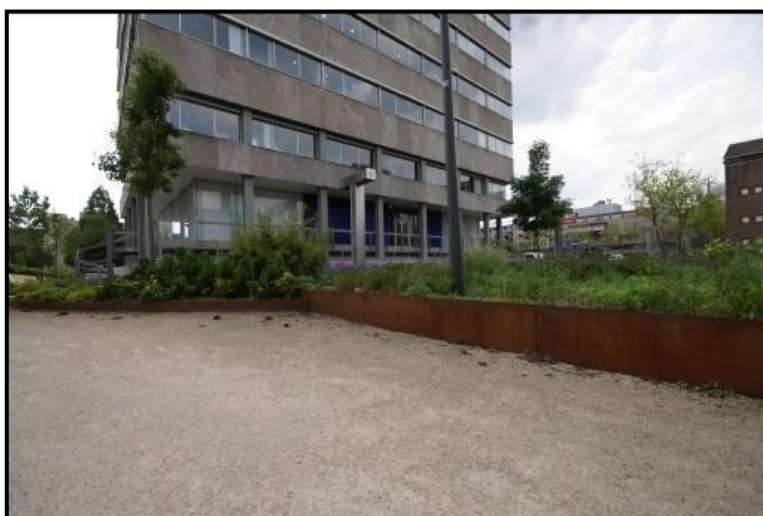
Borderrand van cortenstaal bij het gemeentehuis te Eindhoven. Dit materiaal is ook zeer bruikbaar voor boomborder randen.
