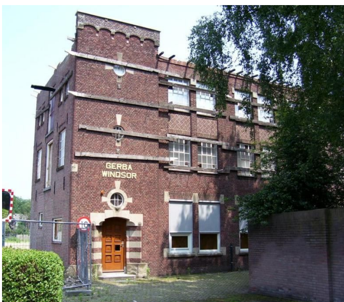
Figuur 2.2: gevel kantoor Gerba Windsor
