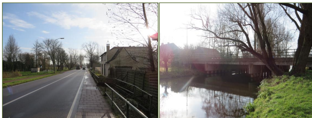
Foto's: Eindhovenseweg en Dommel aan overzijde van de weg.
