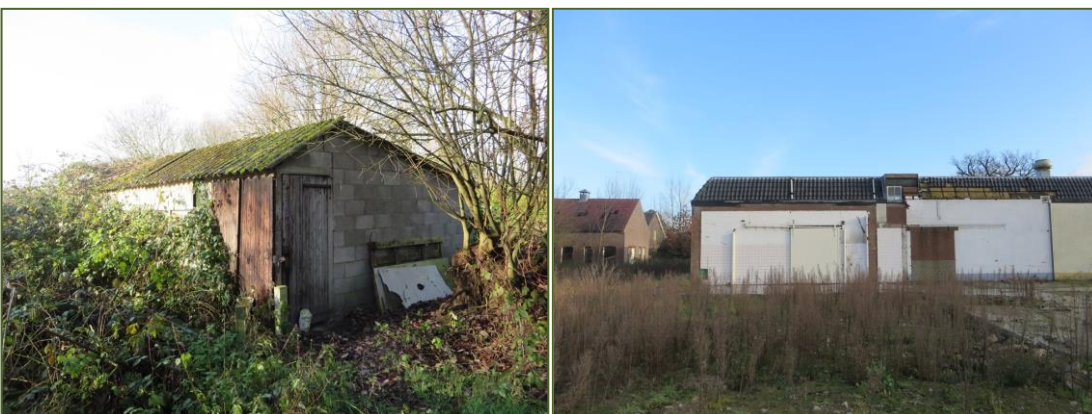
Foto's: Indrukken te amoveren schuur en aangebouwde deel monumentaal pand nr. 12.
