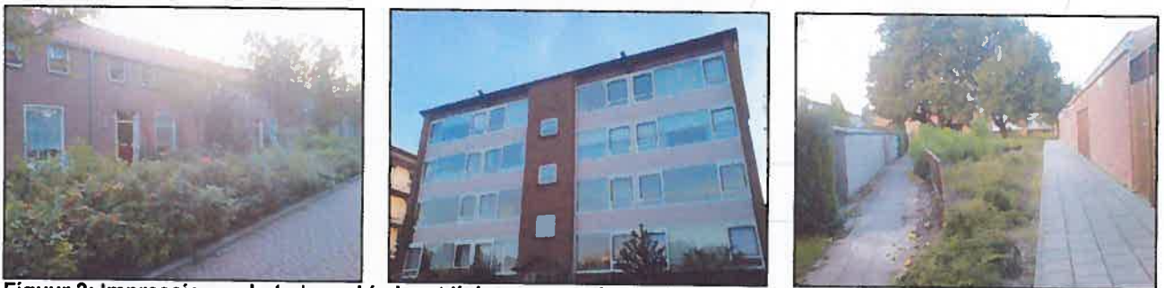
Figuur 2: Impressie van het plangebied met links een van de woningen met oranje daken met de aanwezige groenstructuur, in het midden het appartementen complex en rechts een boomgroep en plaatselijk openbaar groen.
