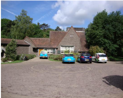
Bebouwing behorende bij het waterleidingbedrijf
