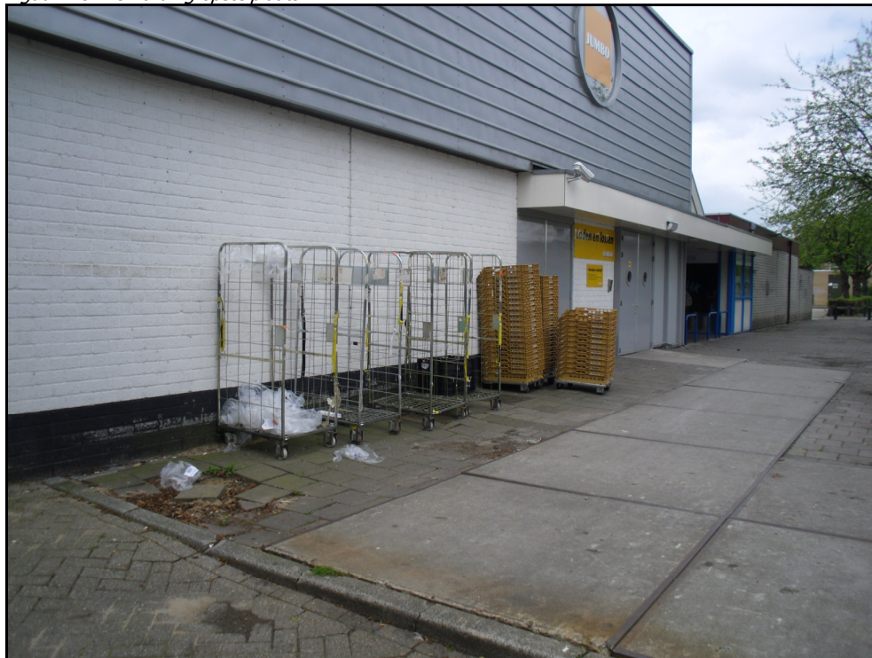
Figuur 2.5: Verharding opstelplaats
