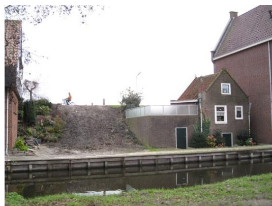
Gat gevelwand bij Noordeinde 65
