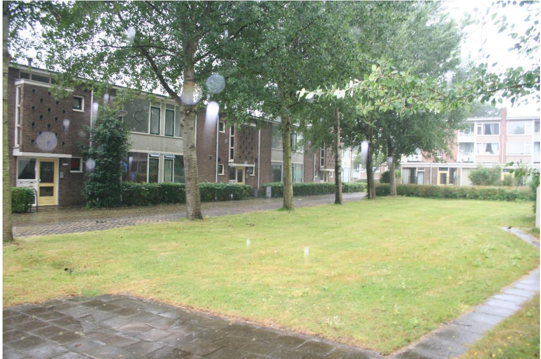
In de gebouwen zijn Invliegopeningen aanwezig
